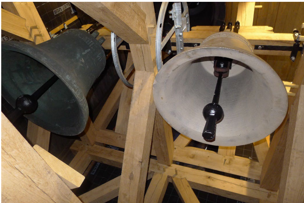
Abb. 3: Einbau neuer Glockenstuhl mit renovierten Glocken in 2020
